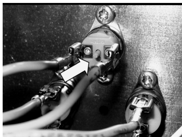
Wymiana ogranicznika temperatury (w przypadku usterki). Może być przeprowadzona tylko przez fachowca!
